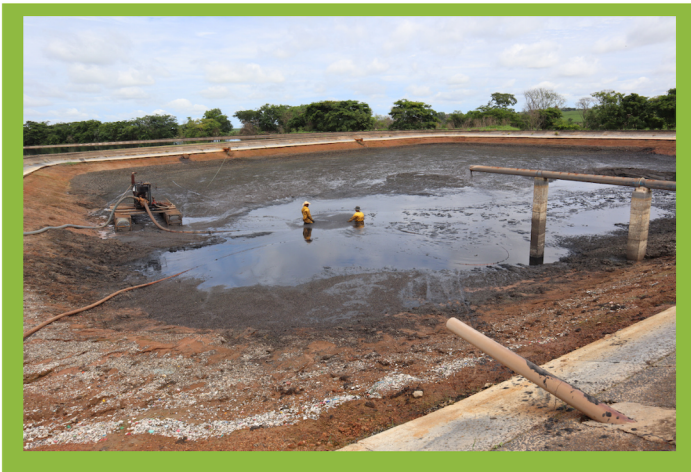
Finalização da limpeza na lagoa
